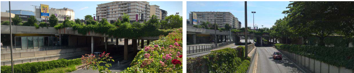
Fig.24 : Trémies sous la place Albert 1er
