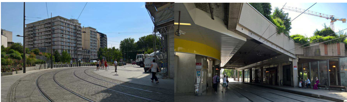
Fig.25 : Ligne A du tramway et station tram sous la place Albert 1er
