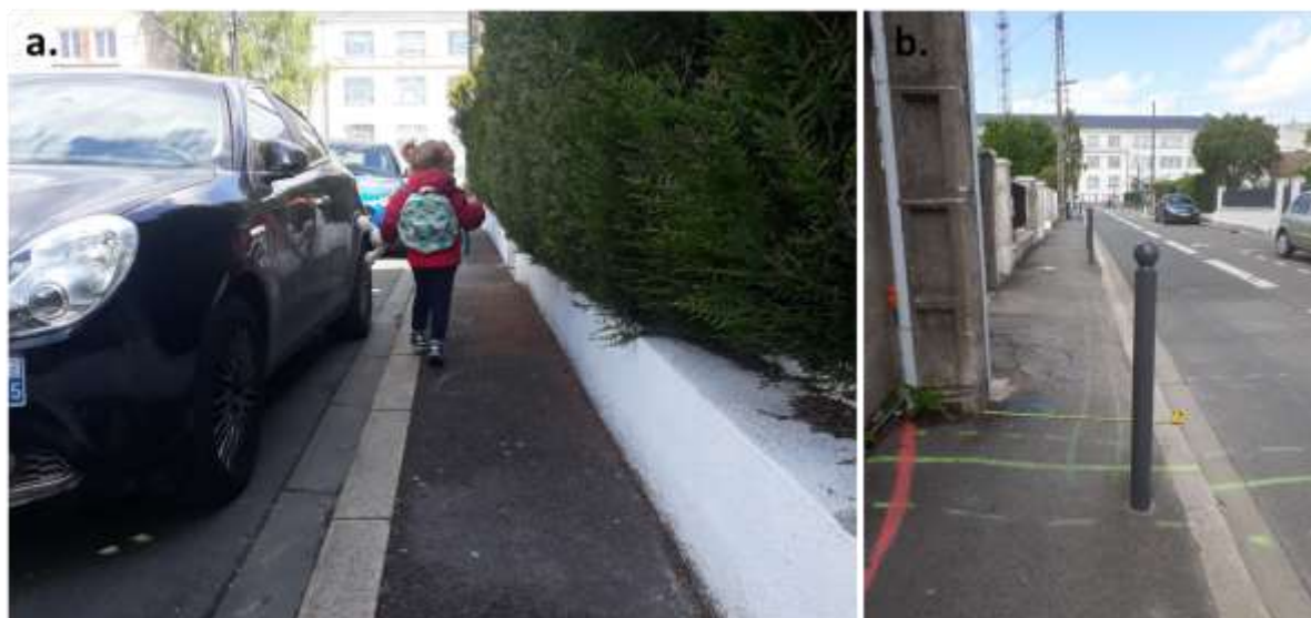
Figure 15 : a. Illustration de la configuration du trottoir côté école au niveau de l'étoile orange indiquée sur la Figure 14: le trottoir fait à plusieurs endroits moins de 65 cm au sol (hors problème de haie non taillée). b. Le trottoir opposé ne respecte pas non plus les normes d'accessibilité (au niveau du mètre ruban, il fait moins d'un mètre ; avec le potelet juste avant, la largeur effective est de l'ordre de 70 cm)
