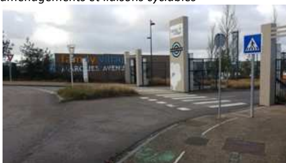
Exemple 4 - Insertion ou sortie d'aménagement dangereuses
