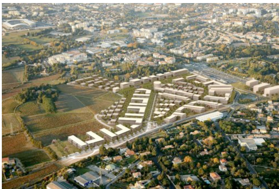
Ecoquartier Les Grisettes, vue aérienne (Source : http://lesgrisettesmontpellier.wordpress.com/ )
